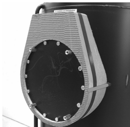
Isolation arrière de la bride installée
