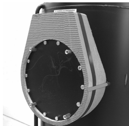
Fissare l'isolamento della flangia posteriore
