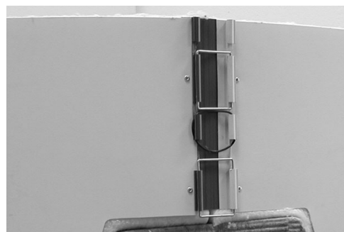
Position de l'isolation au milieu alignée sur la bride
