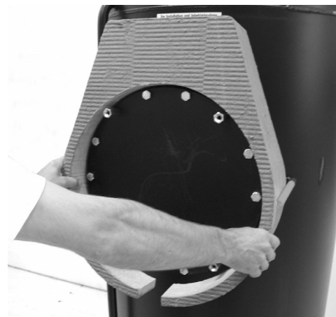
Hintere Flanschisolierung anlegen
