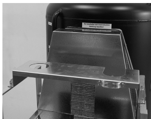
Tôle de la console installée
