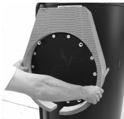
Installation de l'isolation arrière de la bride
