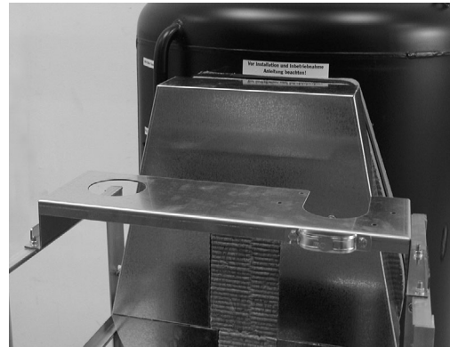
Konsolenblech montiert
