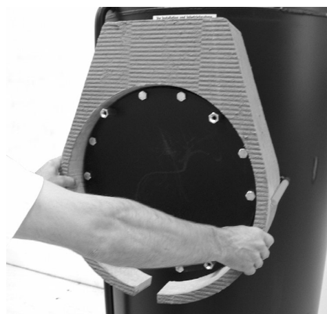
Applicare l'isolamento posteriore della flangia
