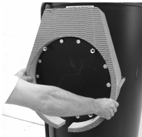
Colocar o isolamento do flange traseiro
