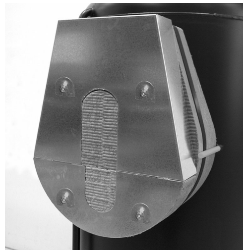
Vordere Flanschisolierung montiert
