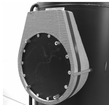
Hintere Flanschisolierung befestigt
