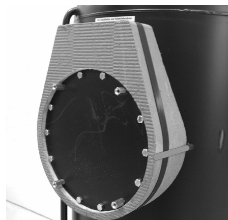
Aislante trasero de la brida fijado
