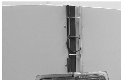
Speicherisolierung mittig zum Flansch
