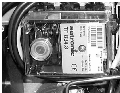
SÖ-NT: desbloqueo de la centralita
